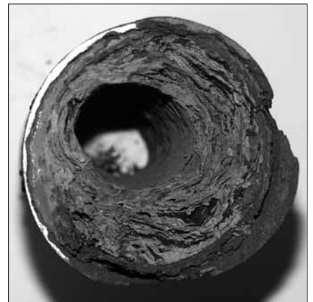
Ett avloppsrör före rensning
