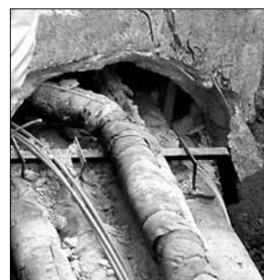
En uppgrävd kulvert där man har lyft bort locket. Två värmerör samt till vänster bredbandsfiber.
